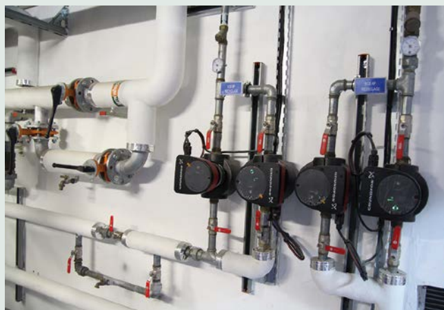
Réalisés par la Cram, les travaux de la sous-station de la tour Z ont été soignés, comme le montre la partie pompes des réseaux ECS basse et haute pression.
